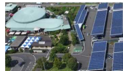
太陽光発電施設の設置
